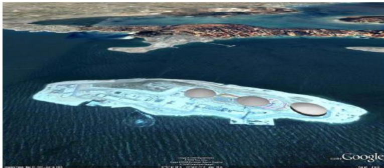
Εικόνα 1: Εναέρια προσεγγιστική όψη τερματικού σταθμού νήσου Ρεβυθούσας με την εγκατάσταση της 3 ης δεξαμενής.
