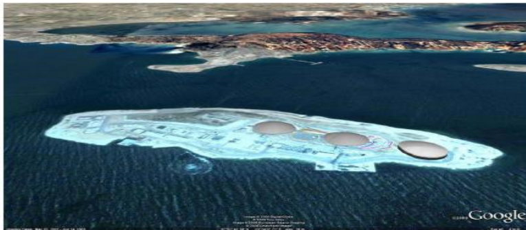
Εικόνα 1: Εναέρια προσεγγιστική όψη τερματικού σταθμού νήσου Ρεβυθούσας με την εγκατάσταση της 3 ης δεξαμενής.
