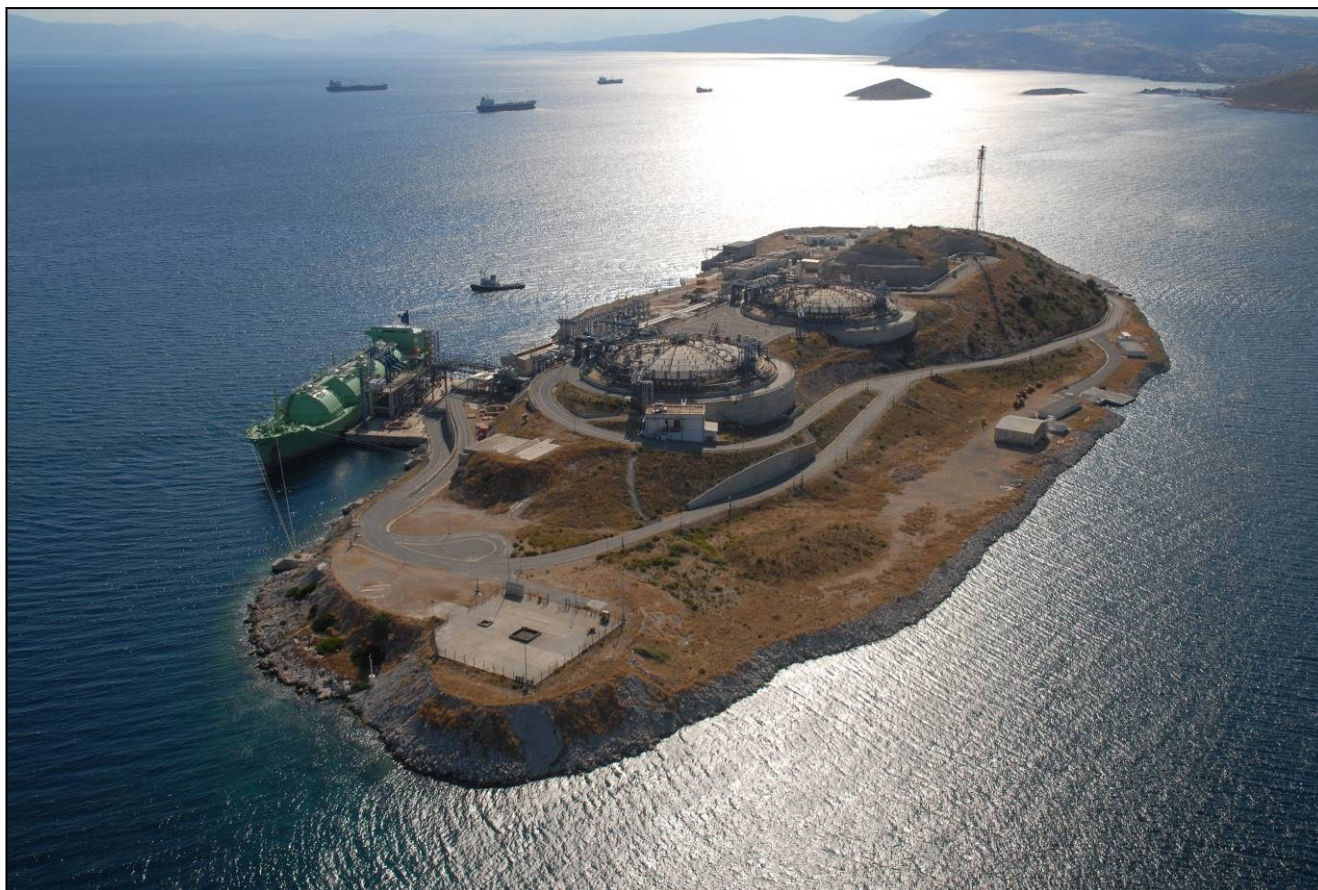
Τερματικός Σταθμός Υγροποιημένου Φυσικού Αερίου Ρεβυθούσας
