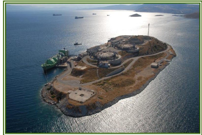
Τερματικός Σταθμός Υγροποιημένου Φυσικού Αερίου Νήσου Ρεβυθούσας
